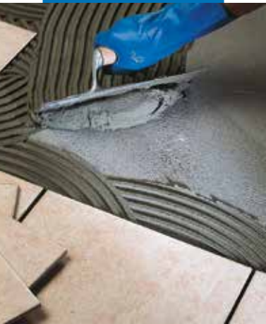
Montaż płytek typu monocottura na podłozie
